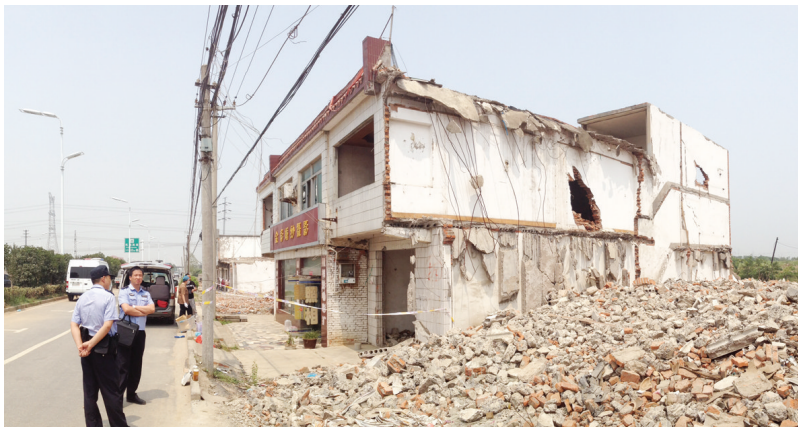
此处影楼周边建筑都已拆除
