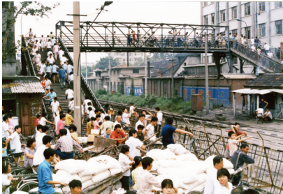
蚌埠延安路天桥
