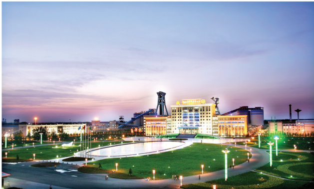
现代化顾桥矿夜景璀璨
