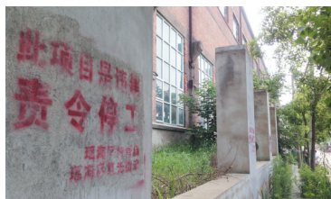
围墙外被喷上“此项目违建，责令停工”
