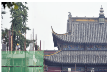
合肥明教寺今年四月底开始修缮,近日,老明教寺外围主体建筑已开始搭建,预计2016年初修缮工程可全部完工重新对市民开放。 记者 黄洋洋/图
