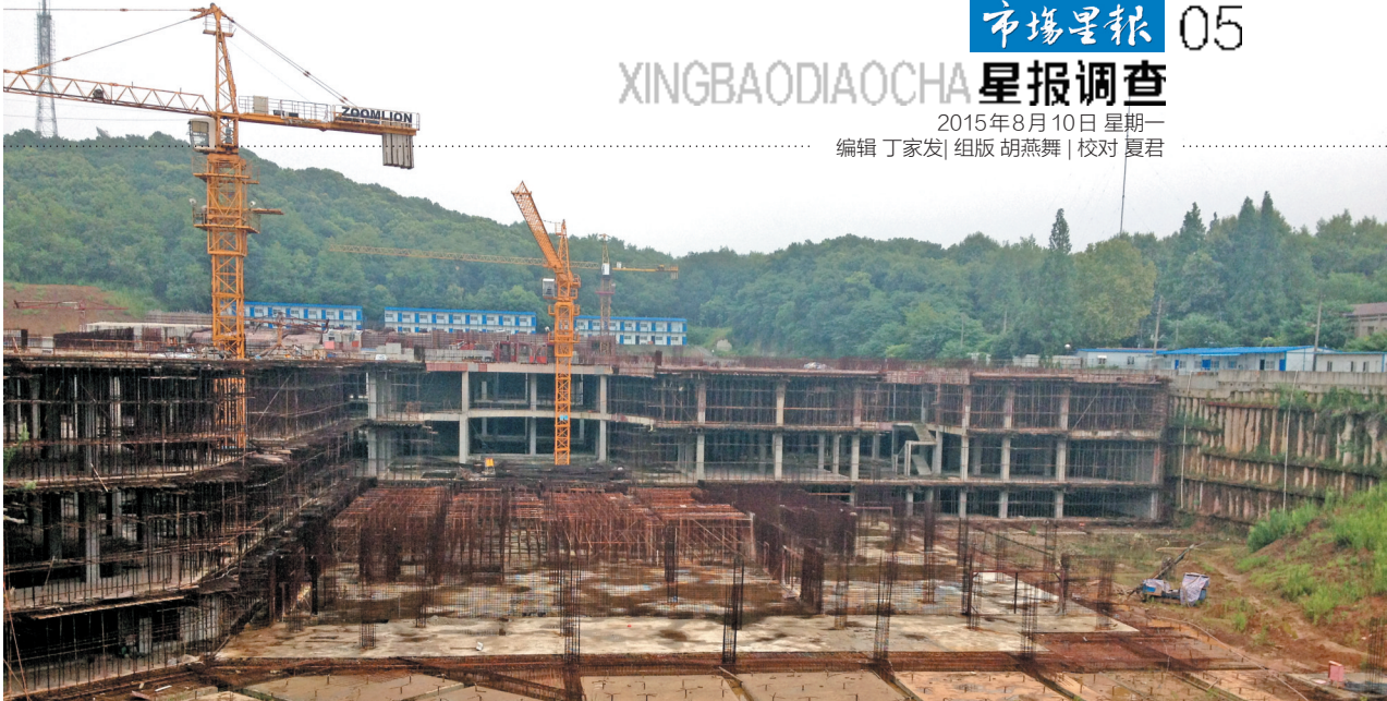
停工达10个多月的“赭山印象”项目工地
