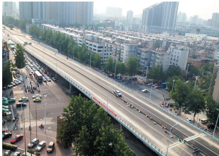
南熏门桥桥面主体完工
