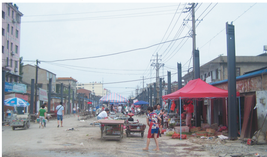
菜市场两侧钢结构的柱子已经建好
