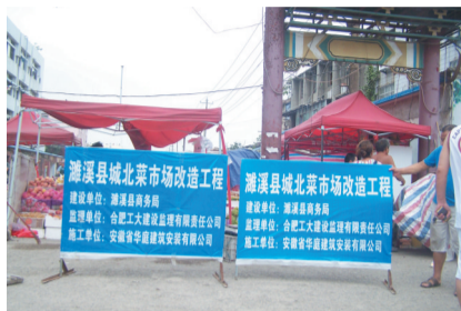
菜市场入口的施工牌
