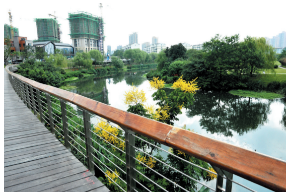
合肥南淝河岸新建大型观景台,已向市民开放。观景台位于西一环南淝河北岸,木制的观景台,造型别致的遮阳走廊,河边风景尽收眼底,成为南淝河沿岸又一道亮丽风景线。
