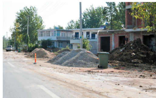
建筑材料占了大幅路面
