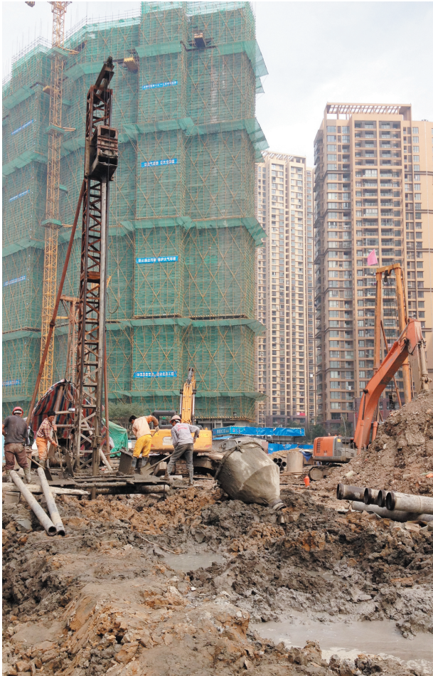
施工处为3号楼,前方尚未完工的楼为2号楼
