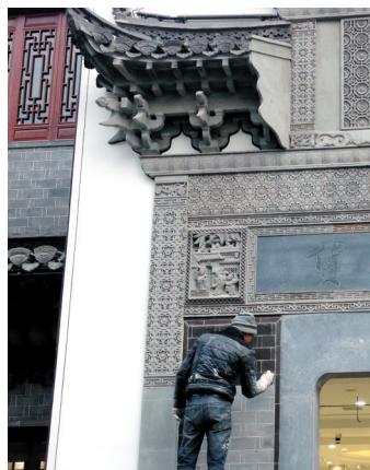
工人正在施工
