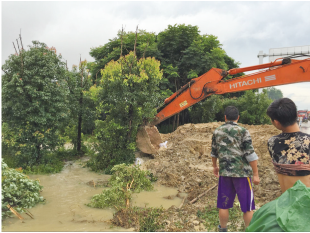
加固施工现场
