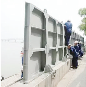
哈尔滨防汛闸板安装演练
