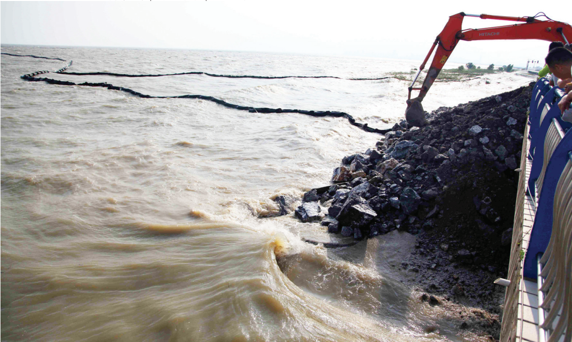
挖掘机现场抢险中
