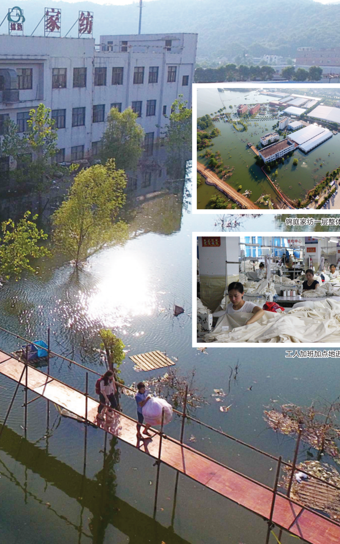
锦庭家纺的厂房被大水环绕，一层整体浸泡在水中
