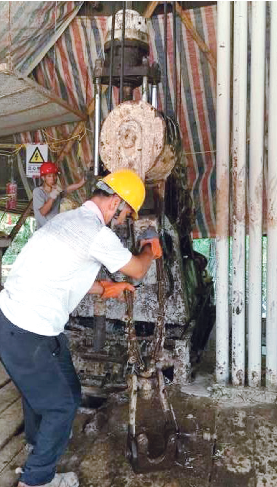
钻探工人徐新站在钻机前，专注地进行着操作
