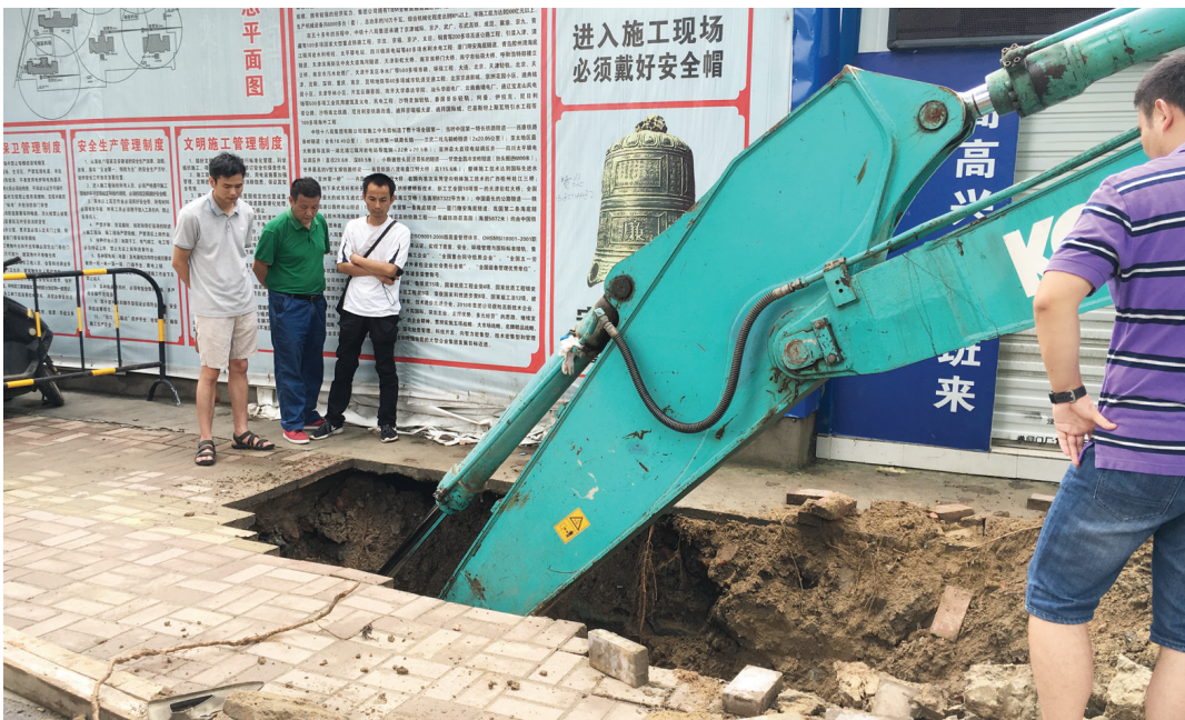
工作人员在抢修塌陷的大坑
