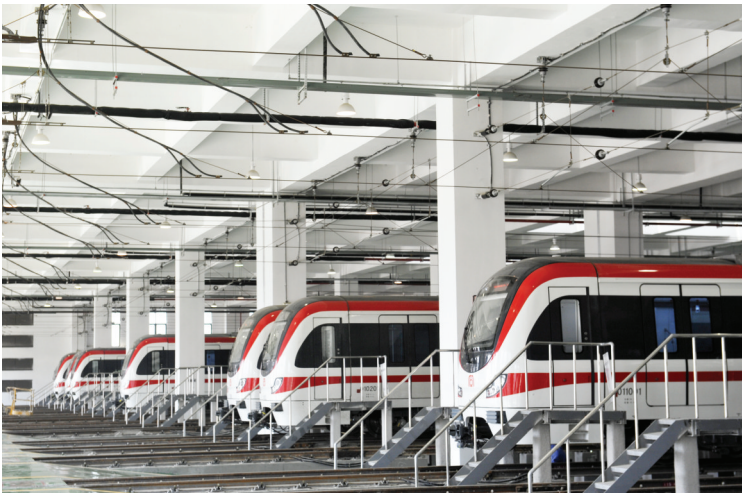
珠江路车辆段的地铁运用库
