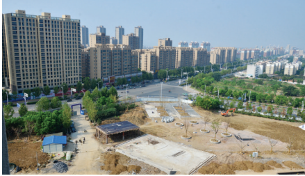
正在建设中的口袋公园
