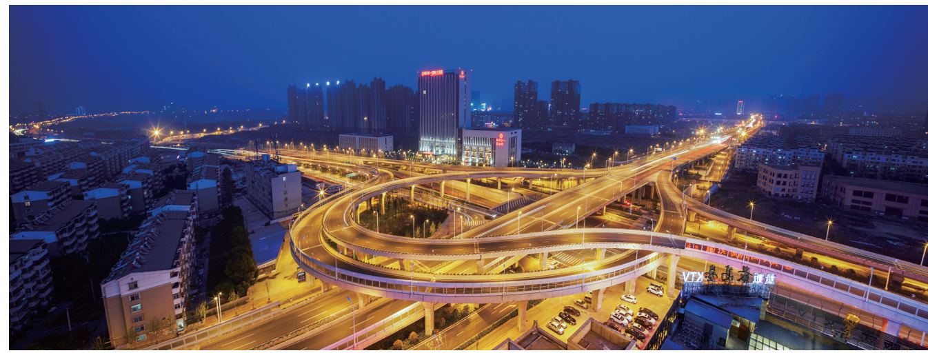
四通八达郎溪路立交桥 王斌/图
