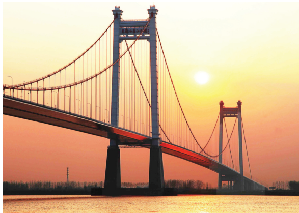
马鞍山长江大桥
