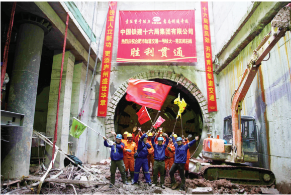
轨道1号线顺利洞通
