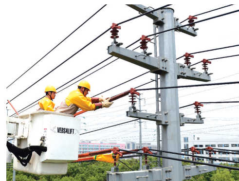
合肥供电公司员工开展带电检修作业,保障居民用电。
