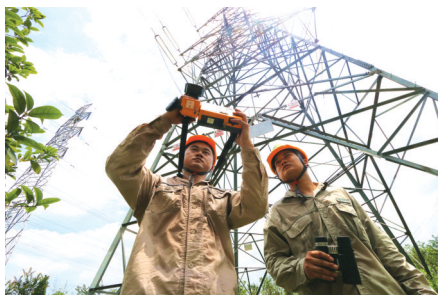
合肥供电公司员工对全市重点线路进行密集巡视与测温。
