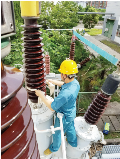
炎炎夏日战斗在检修现场
