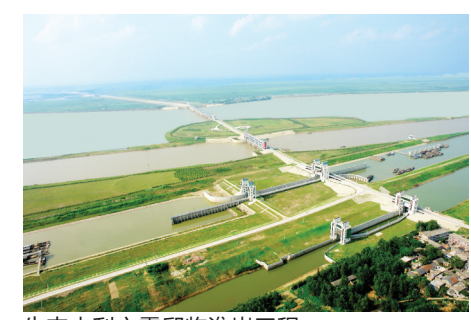
生态水利之霍邱临淮岗工程
