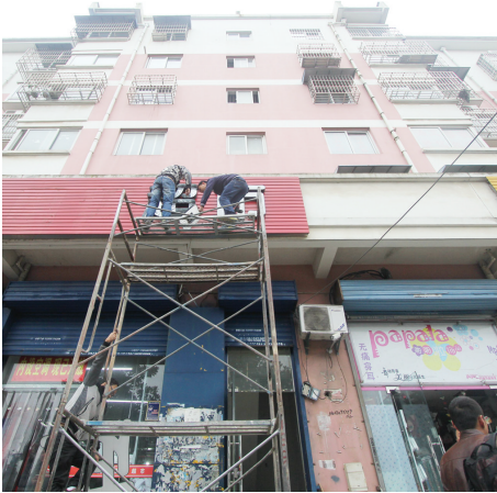
林业小区3号楼2单元进场施工
