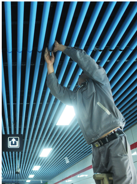
工作人员对站内装修进行最后检查
