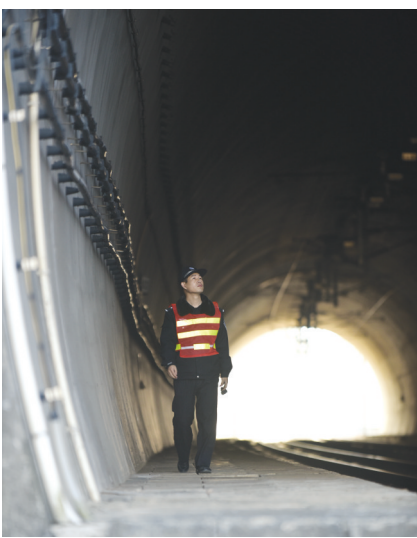
胡洋趁着列车通过间隙检查隧道内的安全情况
