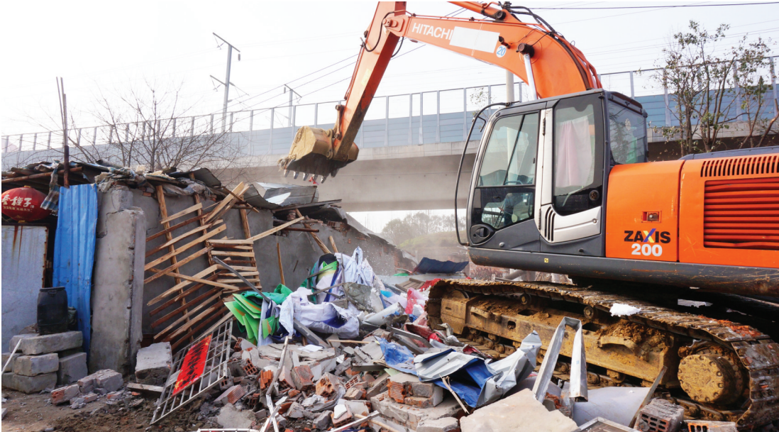
拆除违章搭建
