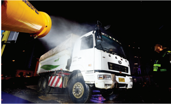
除尘防霾“水炮”亮相工地
