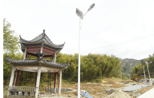
金寨县花石乡大湾村铺上了水泥路，架设了路灯
