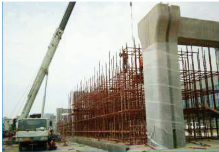
铜陵路高架北延工程施工现场
