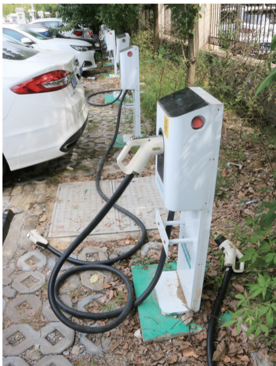
和一花园的充电停车位,几个快充连接器散落在地上
