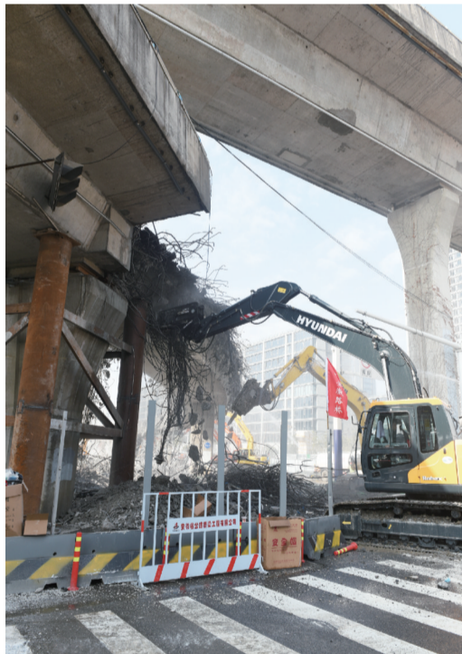
畅通二环(西南环)工程施工现场
