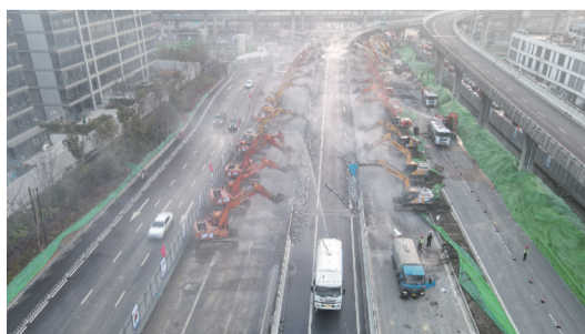
30台大型破碎机分列匝道桥两侧同时进行施工(组图)
