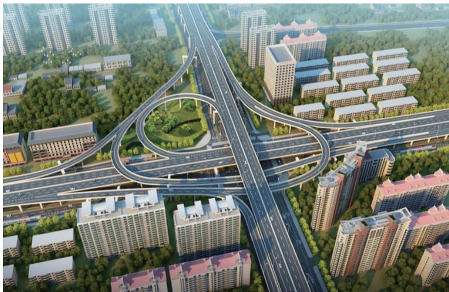
北路、合瓦路、利辛路、阜阳北路、嘉山路7条既有道路相交。高架桥段自颍上路以西约290米处起桥,在嘉山路以东约200米处落地,全长约2.3公里。高架桥主桥标准段宽25.0米,双向6车道。在北二环与阜阳路交汇处设置互通立交一座;在蒙城北路西侧设置1组平行上下匝道,共计8条匝道。在凤淮路西侧新建一座人行天桥。
