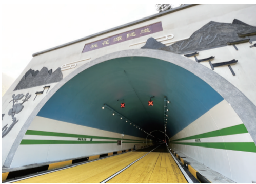
芜黄高速桃花潭隧道
