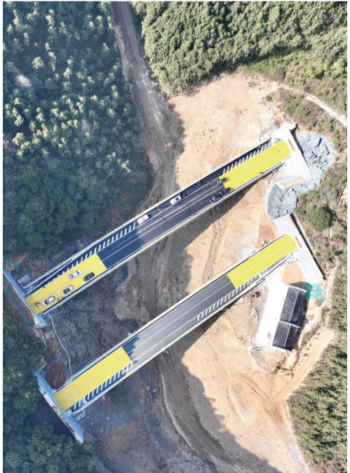
空中俯瞰芜黄高速隧道连接处
