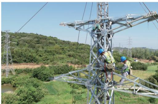
8月8日上午10时,在庐江县石头镇的金牛至庐城110千伏线路工程建设现场,电工正在40米高空中进行组塔作业。该工程为110千伏庐城变电站配套线路工程,为了确保项目按期投运,合肥供电公司正组织人员力量加快推进施工,计划9月中旬完成全部49基铁塔新建并正式进入下阶段线路架设作业。 李岩
