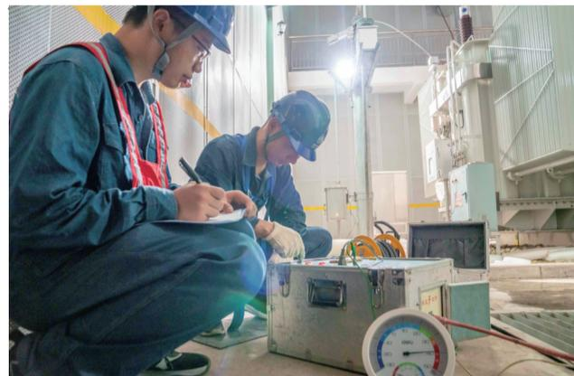
近日凌晨2点,在安徽省宣城市中心城区的110千伏中心变电站2号主变室内,宣城供电公司检修人员利用夜间低负荷时段紧急消除2号主变油温异常、油位高等缺陷,6小时的变压器停电检修,客户零感知。 韦振 孔超 曹开发 文/图
